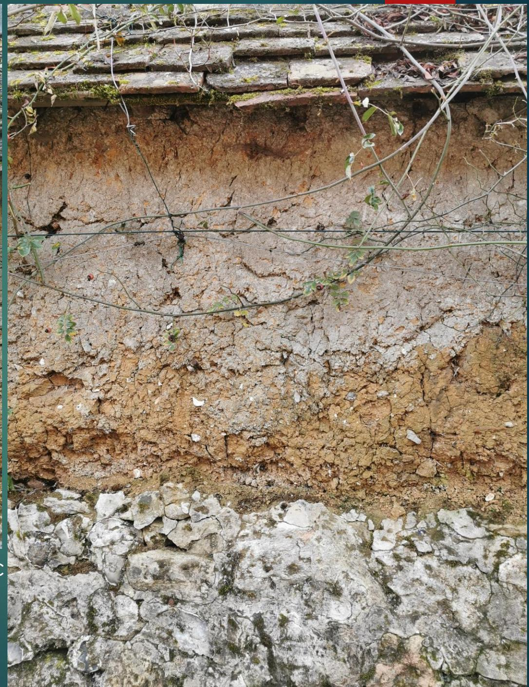
Mur en pisé. Maçonnerie faite avec de la terre argileuse et des cailloux, que l'on comprime sur place dans un moule fait de deux banches.
