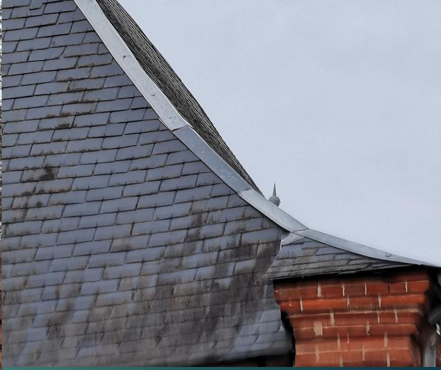
Le coyau est une petite pièce de bois posée dans une toiture à la base des chevrons afin d'éloigner les eaux pluviales du bas des murs.
